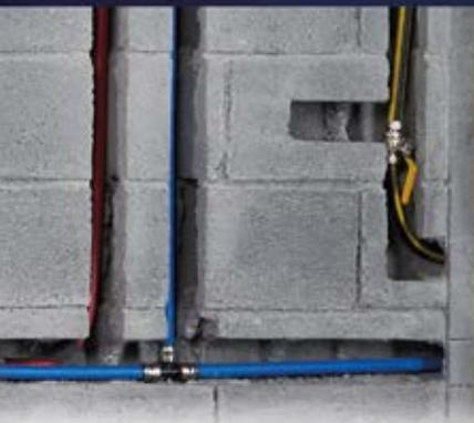
Tubería PEX TX-A\* y TX-R / Tubería PE-AL-PE TG-D\*
